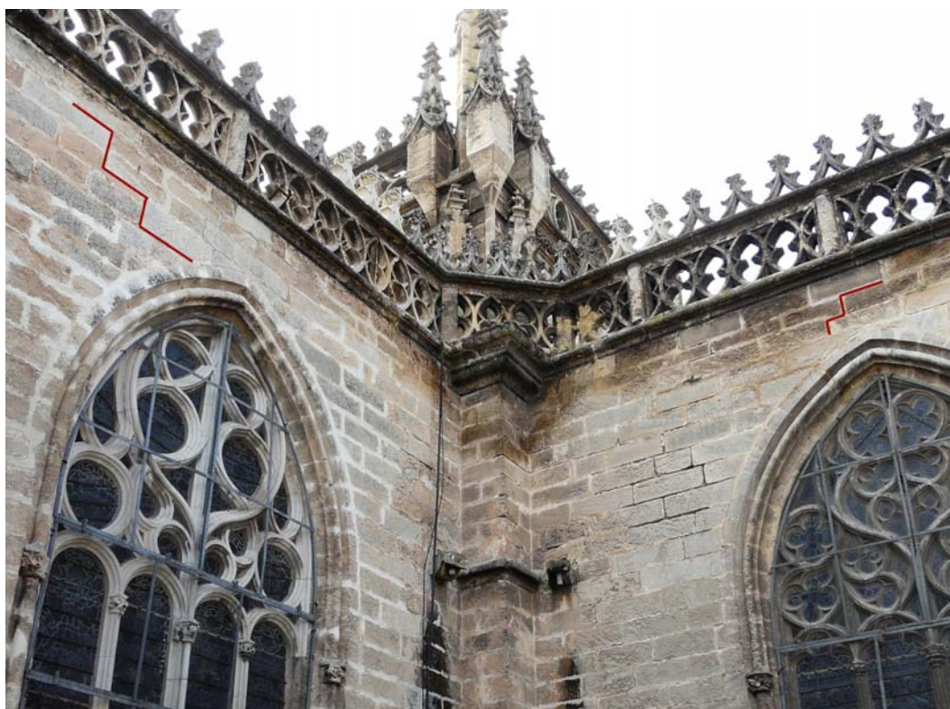
Fig. 9- Interfaz de encuentro entre la fábrica reconstruida y la original sobre las ventanas de la nave mayor y del crucero en la esquina noroeste.
