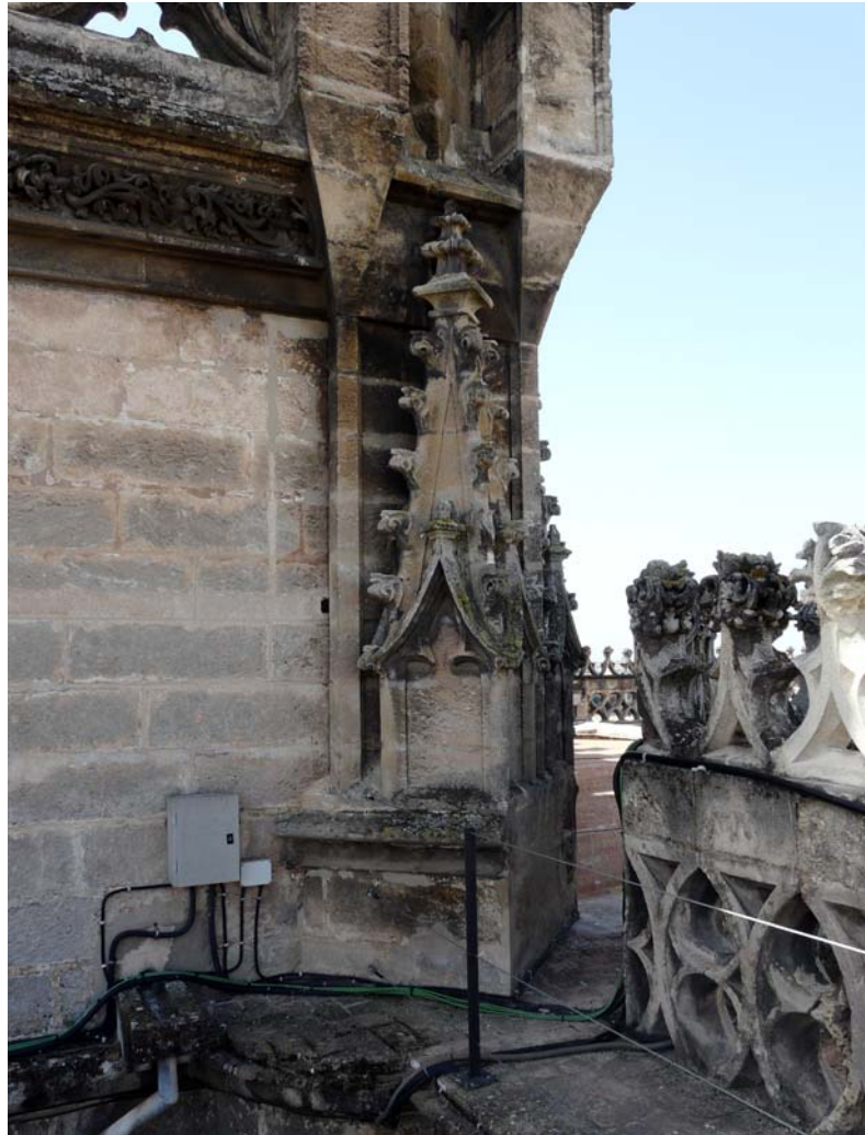
Fig. 11- Arranque del estribo en la esquina noroeste del cimborrio.
